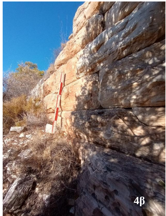
Εικ. 3α,β,γ,δ. Μεγάλου μεγέθους δεξαμενή, με υδραυλικό κονίαμα εσωτερικά, με λίθινη στέγαση, λίθινων λαξευμένων ογκόλιθων, δομημένων κατά το εκφορικό σύστημα.
